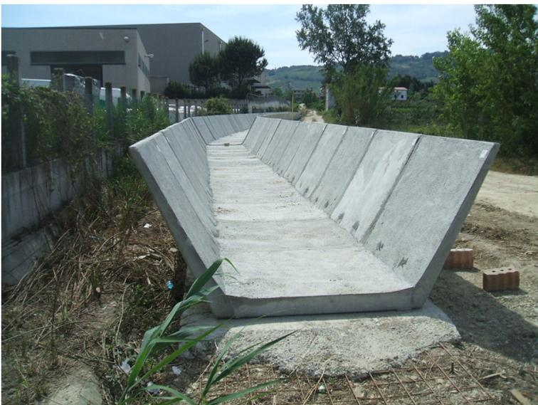
**Foto 6 canalette in calcestruzzo armato vibrato a sezione policentrica**
