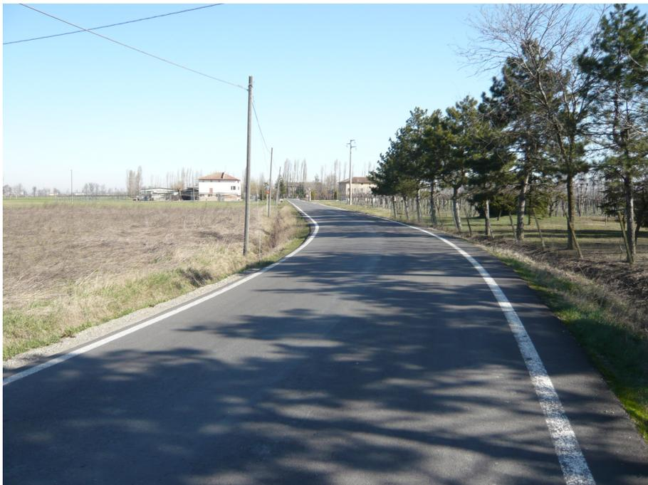
**Foto 14 VIA CARPI ESISTENTE - da allargare zona attraversamento metanodotto SNAM**
