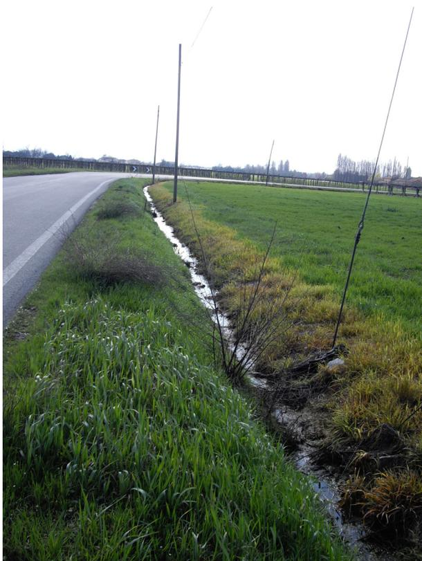
**Foto 12 VIA CARPI ESISTENTE - da allargare e rivestire con canalette in cls**
