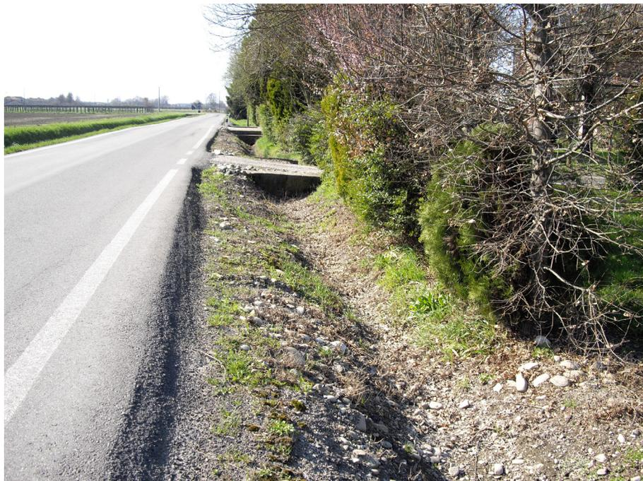
**Foto 13 VIA CARPI ESISTENTE - sistemare banchine**
