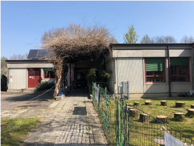
Lato Sud – ingresso
