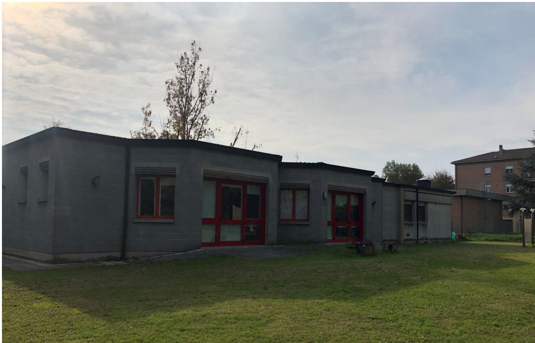
Figure 3 - Vista retro del fabbricato
