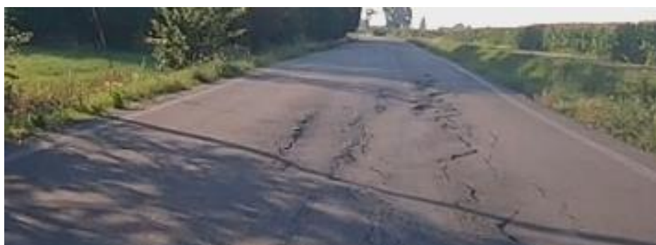
Asfalto di via Carpi in un tratto ad est dell'intersezione con via San Michele
