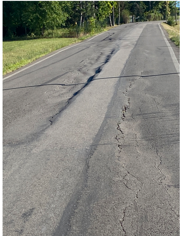
VIA CARPI - stato attuale sede stradale con evidenti e pericolosi dissesti
