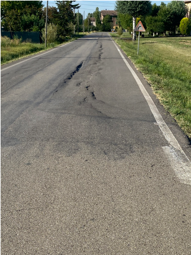
VIA CARPI - stato attuale sede stradale con evidenti e pericolosi dissesti
