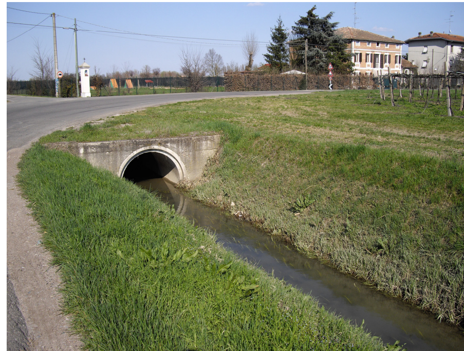
Foto 8 - VIA CARPI ESISTENTE Canale di Trignano da Chiesa di Trignano a curva tombata tratto nord-sud. Oggetto di consolidamento in progetto con canaletta pref.
