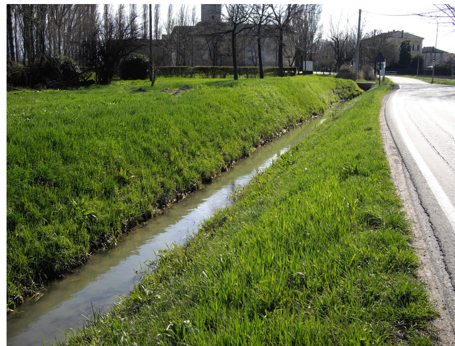
Foto 9 - VIA CARPI ESISTENTE Canale di Trignano da curva tombata tratto est-ovest fino alla curva seguente Oggetto di consolidamento in progetto con canaletta pref.
