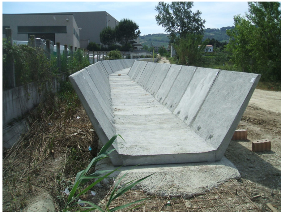
Foto 7 - Consolidamento in progetto del canale Trignano con canaletta pref.
