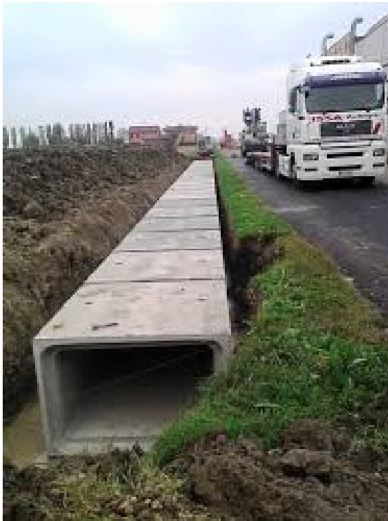
Foto 9 - 10 scatolare chiuso in calcestruzzo armato vibrato per carichi stradali
